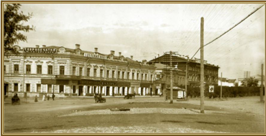
Доходные дома Зеленковых на Большой Саратовской с магазином «колониальных» товаров (ул. Гончарова, 15) и электротeatром «Модерн» (ул. Гончарова, 17), далее по улице – доходный дом Медведевой (ул. Гончарова, 19). Открытка нач. XX в.
