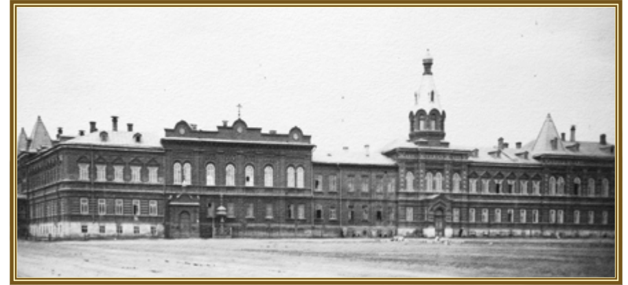
Комплекс зданий Симбирской городской богадельни и детского приюта (Кирпичниково-Конуринская богадельня). Постройка 1894 – 1899 годов. Арх. В.Л. Ивановский. Начало XX века
